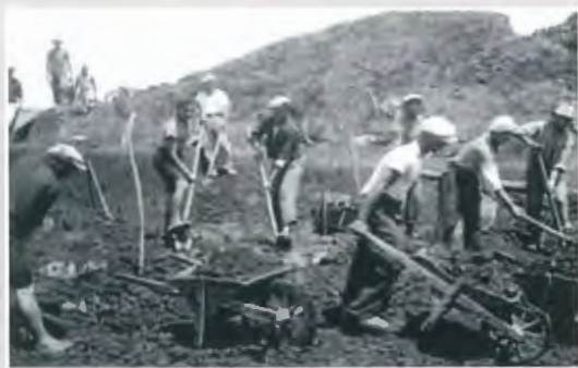
Lavori di bonifica
